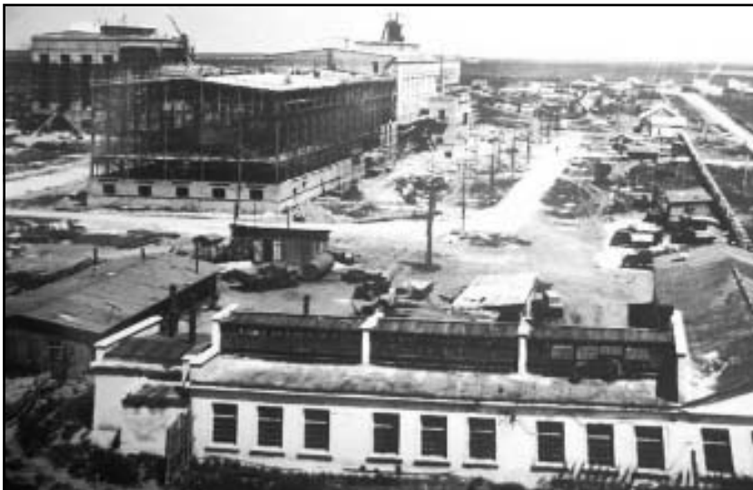
Строительство сахарного завода
