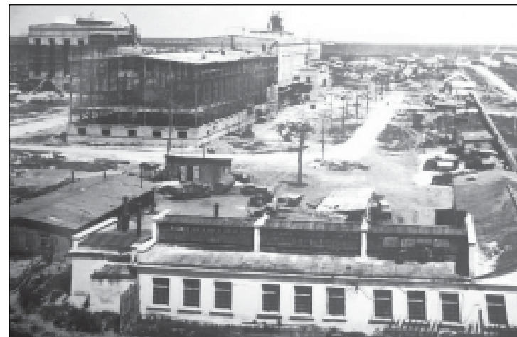
Строительство сахарного завода
