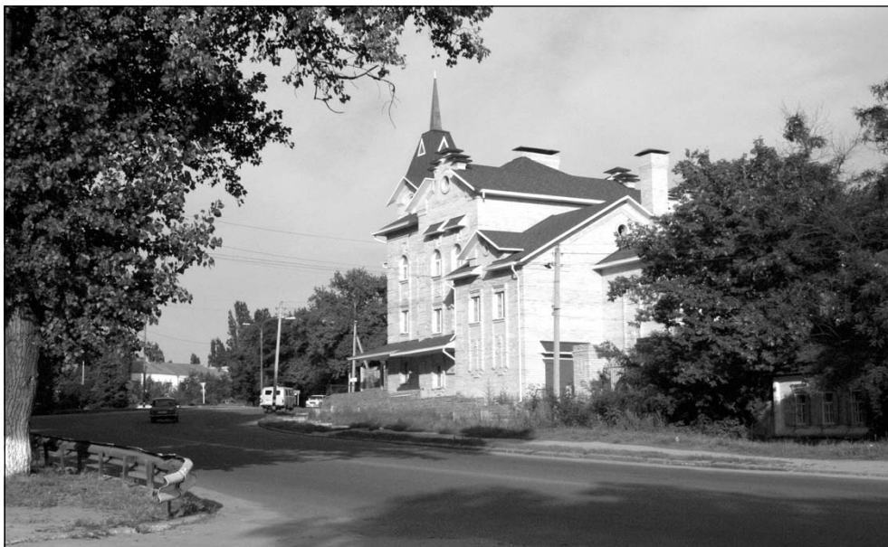
Современная архитектура улицы
